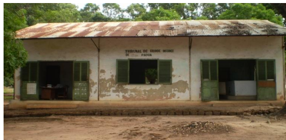
Ancien bâtiment TGI Paoua
