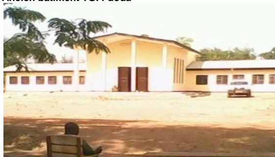
Nouveau bâtiment du TGI de Paoua réceptionné provisoirement le 24 mars 2012
