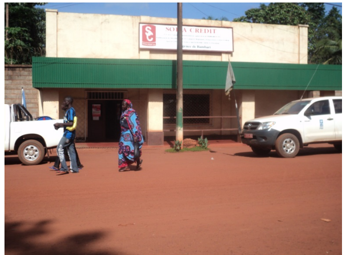
Caisse d'épargne et crédit SOFIA-CREDIT réhabilitée de Bambari
