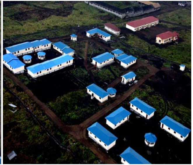
Vue aérienne du centre de formation de Mugunga
