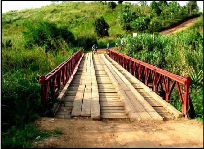
Pont de Kolomani après l'intervention de l'UNOPS
