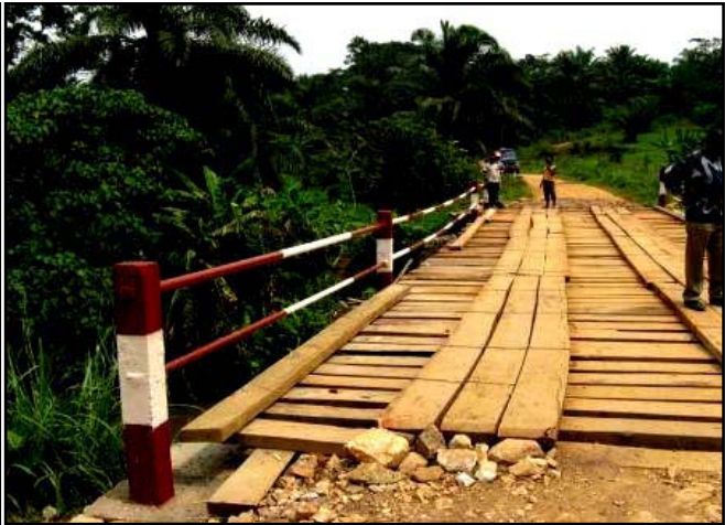
Pont de Mabalako après l'intervention
