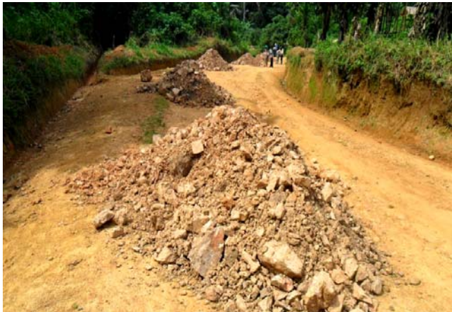
Renforcement de la surface de la route sur l'axe Mabalabo-Cantine
