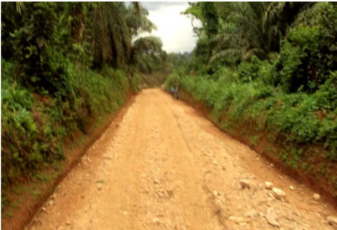
Tronçon de la route sur l'axe mabalabo-cantine après l'intervention
