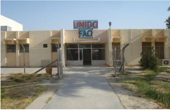
Dewaniyah VTC Entrance
