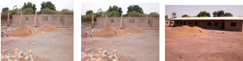
Début des constructions du Centre de formation du projet PBF-CAF-K-7
