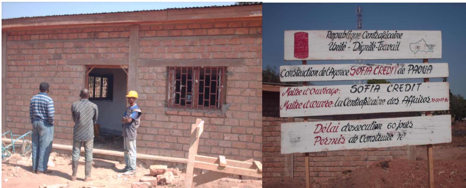
Photo 1 : Travaux de la construction de l'agence SOFIA CREDIT à Paoua située à 505 Km de Bangui.
