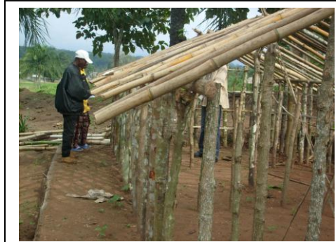
Construction d'une chèvrerie aux M'Brès (Nana-Grébizi)
