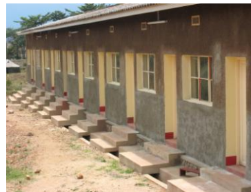
Même bloc rénové, Octobre 2008
