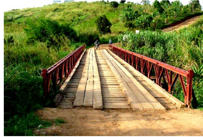
Pont de Kolomani après l'intervention de l'UNOPS
