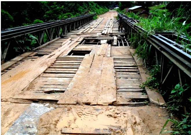
Pont de Mashere dans la Sud Kivu avant l'intervention
