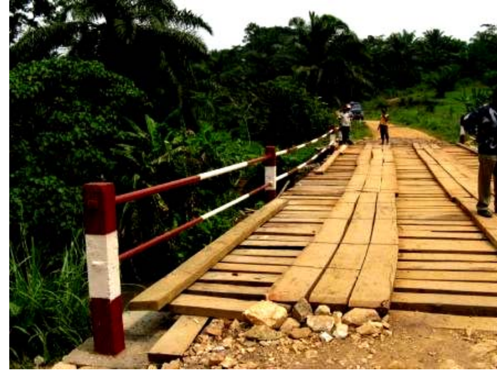
Pont de Mabalako après l'intervention
