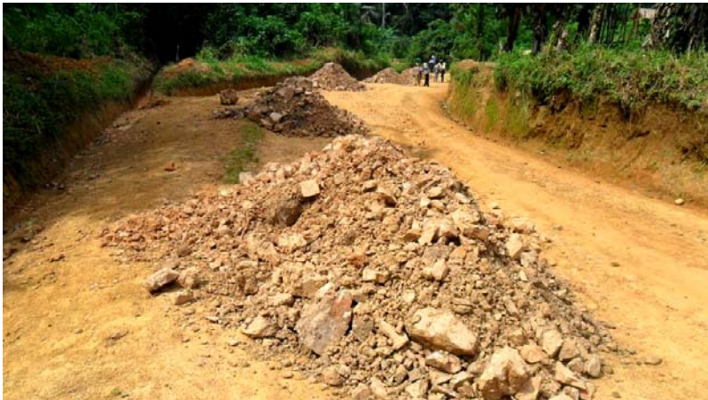
Travaux de renforcement de la surface de la route sur l'axe Mabalako-Cantine
