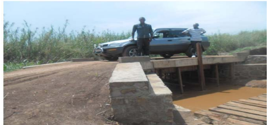
Ponceau réalisée sur la Rivière AVUNI
