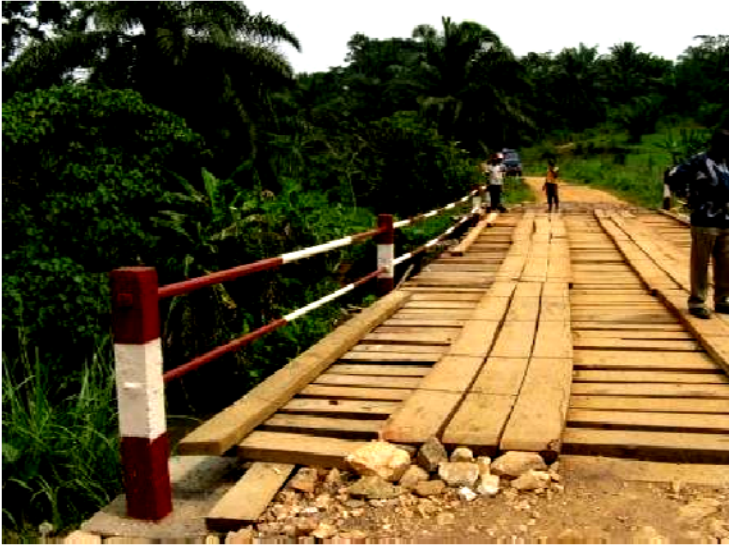
Pont de mabalako après l'intervention
