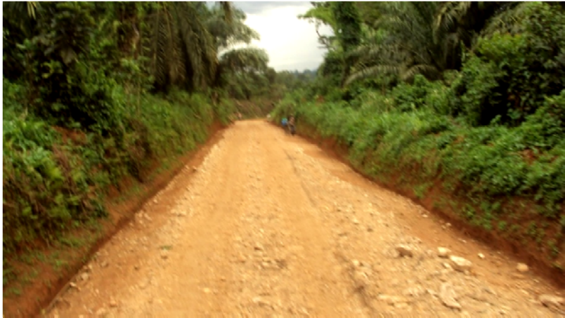
Tronçon de la route sur l'axe mabalabo-cantine après l'intervention
