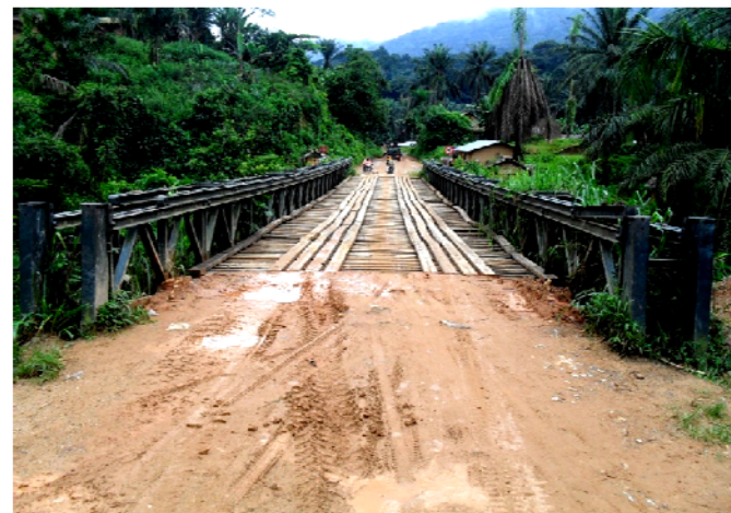
Pont de Mashere dans le Sud Kivu après l'intervention
