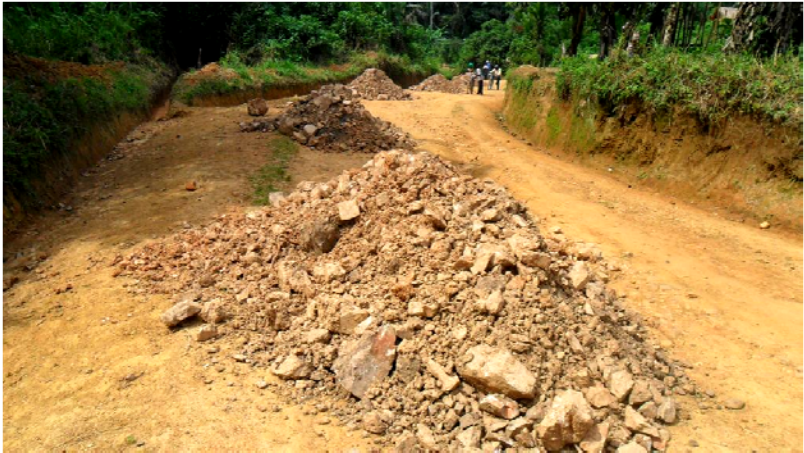
Travaux de renforcement de la surface de la route sur l'axe mabalabo-Cantine
