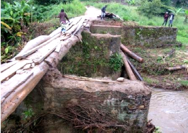
Pont de mabalako avant l'intervention
