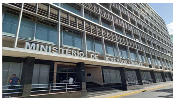
Foto: Edificio sede del MINEM, La Habana Fuente: Equipo de Proyecto-ONURE, 2020
