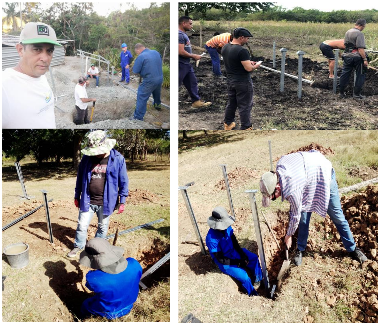
Fotos: Imágenes Removimiento del terreno y ubicación de las estructuras de soporte.
