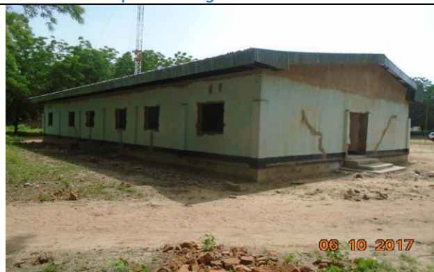
Mairie de Biraou (travaux en cours)
