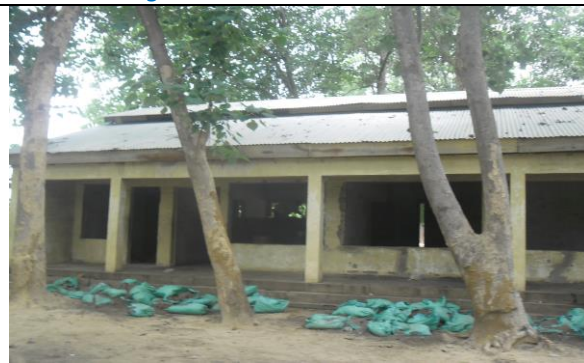
Bâtiment de l'élevage – Biraou (en cours)
