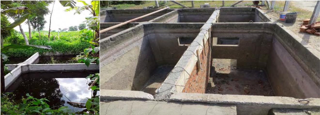
*Fotos: Reconversión de los sistemas de tratamientos actuales (izquierda), de la Empresa Pecuaria Managuaco en biodigestores híbridos cubanos (derecha).*
