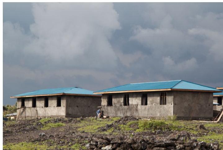
Salles de formation en construction, décembre 2011
