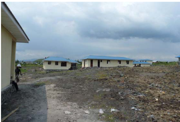
Travaux de finitions en cours sur les bâtiments
