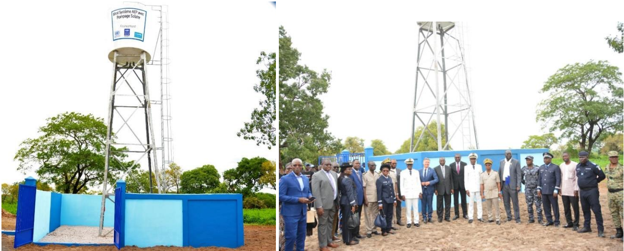
Visite du système de Mini-Adduction Eau Potable réalisé par le Projet à Laleraba
