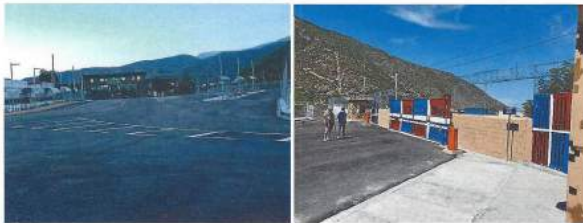
Photo 9.- Nouveau complexe administratif de Malpasso Photo 10.- Nouvelle barrière construite à Malpasso
