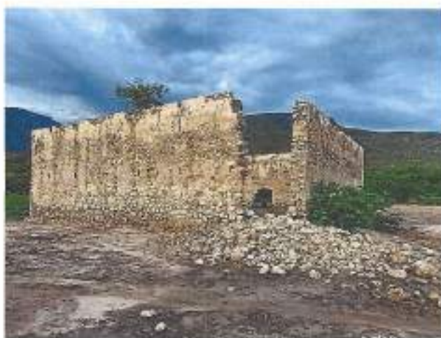
Photo 8.- Ruines de l'ancien bâtiment de la Douane de Nan 40, ancienne route royale Thomasseau-Las Lajas
