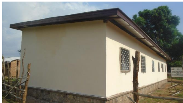
Photo : Nouvelle construction du centre de santé de Ngaloua (façade postérieure en profil)
