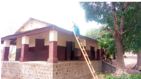
Photo : CS CRPR en cours de réfection
