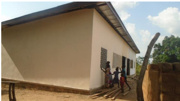
Photo : Nouvelle construction du centre de santé de Ngaloua (façade antérieure en profil)
