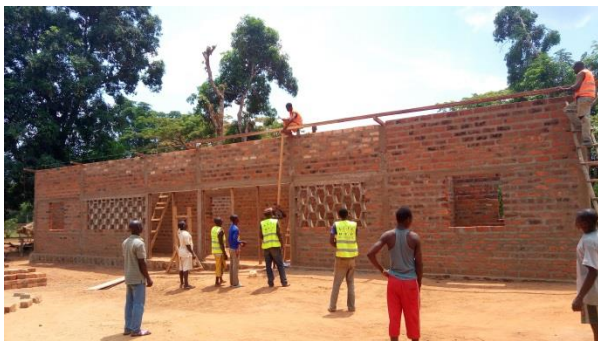
Photo : Nouvelle construction du CS de Lakandja facade antérieure
