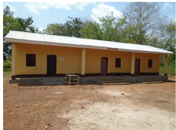
Photo : Nouveau bâtiment de la maternité du CS de Bakala construit à travers l'ONG Rescue Team
