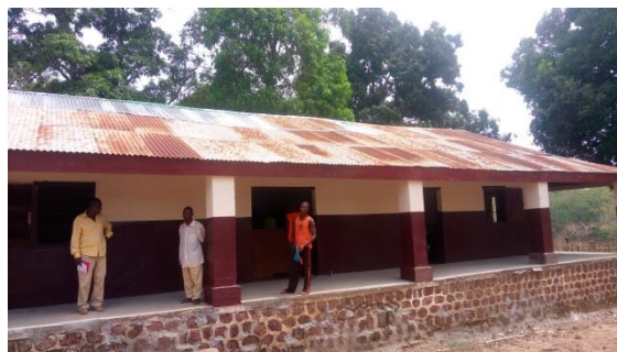
Photo : CS de CRPR réfectionné essentiellement à l'intérieur du bâtiment
