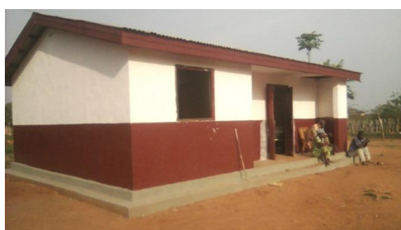
Photo : CS de Seko, bâtiment secondaire réfectionné (salle d'hospitalisation)
