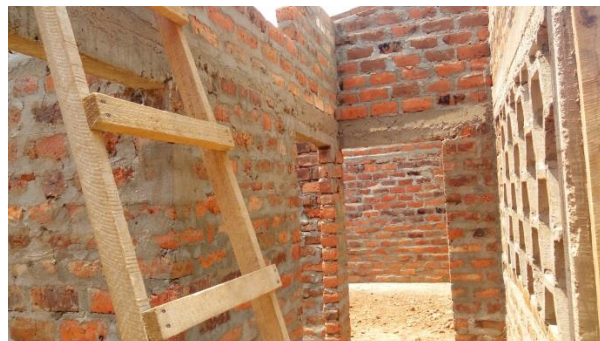
Photo : Nouvelle construction du CS de Lakandja, aspect interne de la construction
