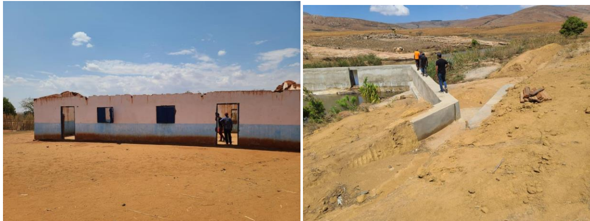
Photo 2 : Foyer communautaire de Bekorobo détruit par le cyclone et mini barrage hydro-agricole non achevé Kelivaho
