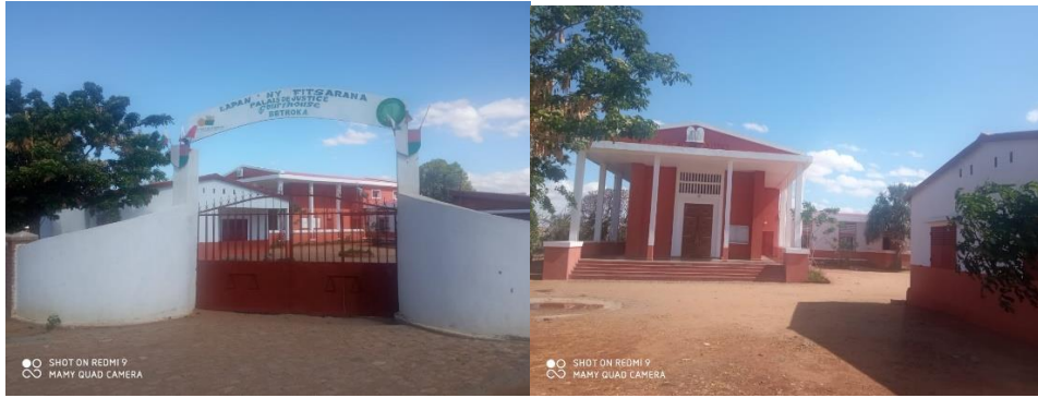
Photo 10 : TPI de Betroka rénové dans le cadre du projet RMIICPS
