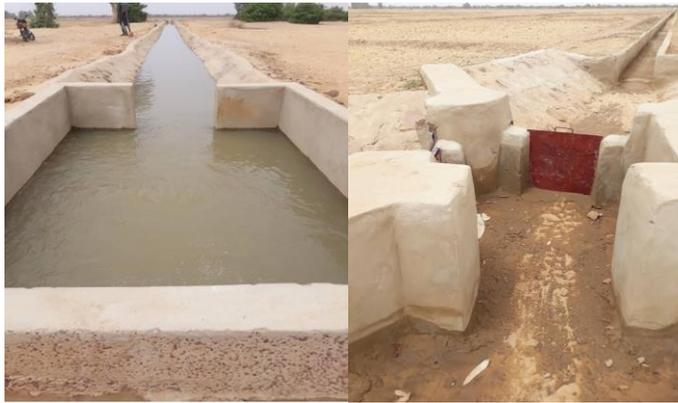
*Photos 9 et 10: Bassin de réception et canal principal en eau au niveau du périmètre irrigué de Soumpi/Niafunké; ouvrage partiteur avec vannette, mai 2022.
