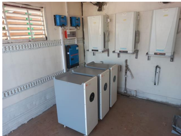
Photo 5 Intérieur de la chambre froide solaire avec les non-bloques et les batteries lithium 6KVA_Crédit Photo DRP Ségou
