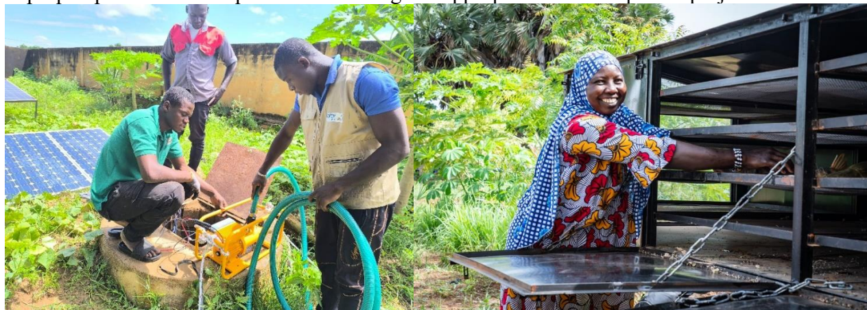
Photo 9 Installation des pompes solaires Crédit photo DRP Ségou et Activité de séchage des poissons au séchoir solaire
