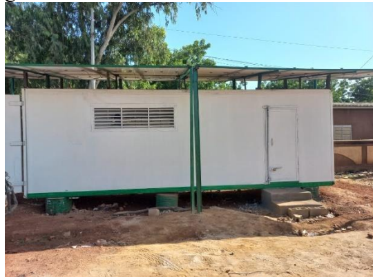
Photo 7 Chambre froide solaire à Ségou_Octobre 2024_Crédit Photo DRP Ségou
