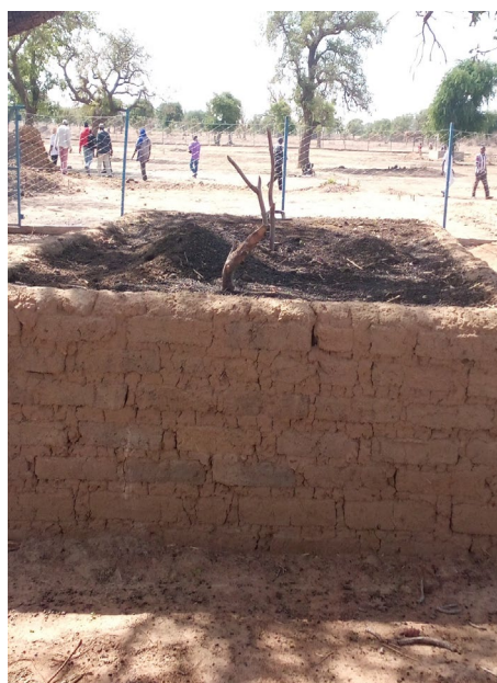
Photo 1: Construction de silo en matériaux locaux facilement accessibles pour l'expérimentation de compostage par les bénéficiaires du PPM d'Adamabougou. (Crédit: ©FAO Mali)
