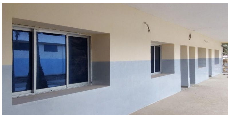
Bâtiment Siège CPS, (ex TGI) en plein réhabilitation
