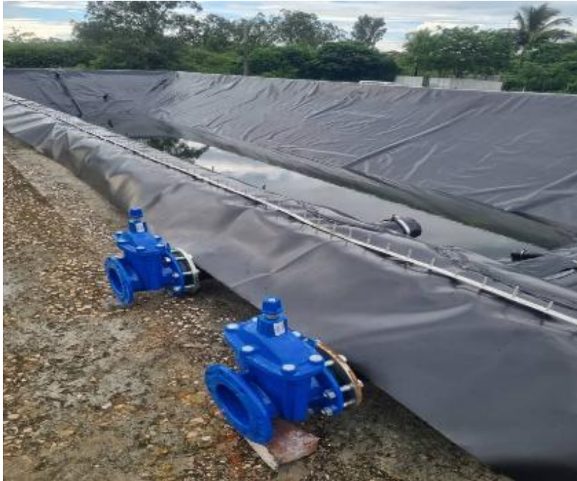
Fotos: Detalles de la instalación de tuberías y válvulas del biodigestor. Fuente: Base de datos del Proyecto FRE local
