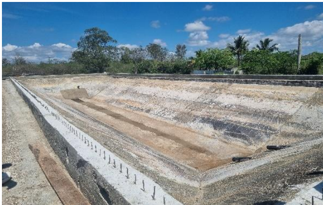
Fotos: Obra civil para la reconversión del tanque de maduración a biodigestor de laguna tapada y colocación de aspersores en el fondo. Fuente: Base de datos del Proyecto FRE local.
