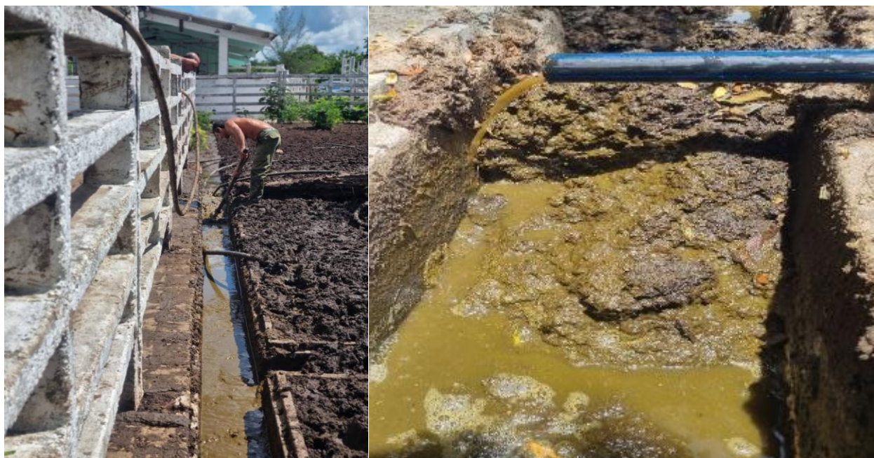
Fotos: Operación en la canaleta a la salida de la nave de ordeño (izq.) y efluente del biodigestor recirculado por bombeo solar (der.). Fuente: Base de datos del Proyecto FRE local.
