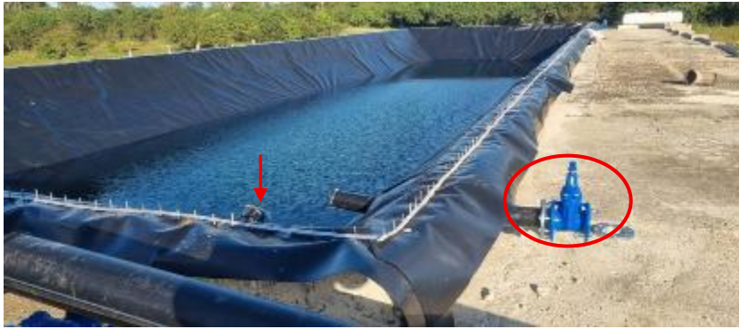
Foto: Tubería de salida que transporta el biogás generado hacia el compresor (identificada con una flecha)
