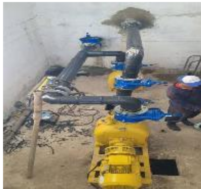
Fotos: Instalacion de balas de almacenamiento de biogás, bomba para extracción de lodo y antorcha. Fuente: Base de datos del Proyecto FRE local.
