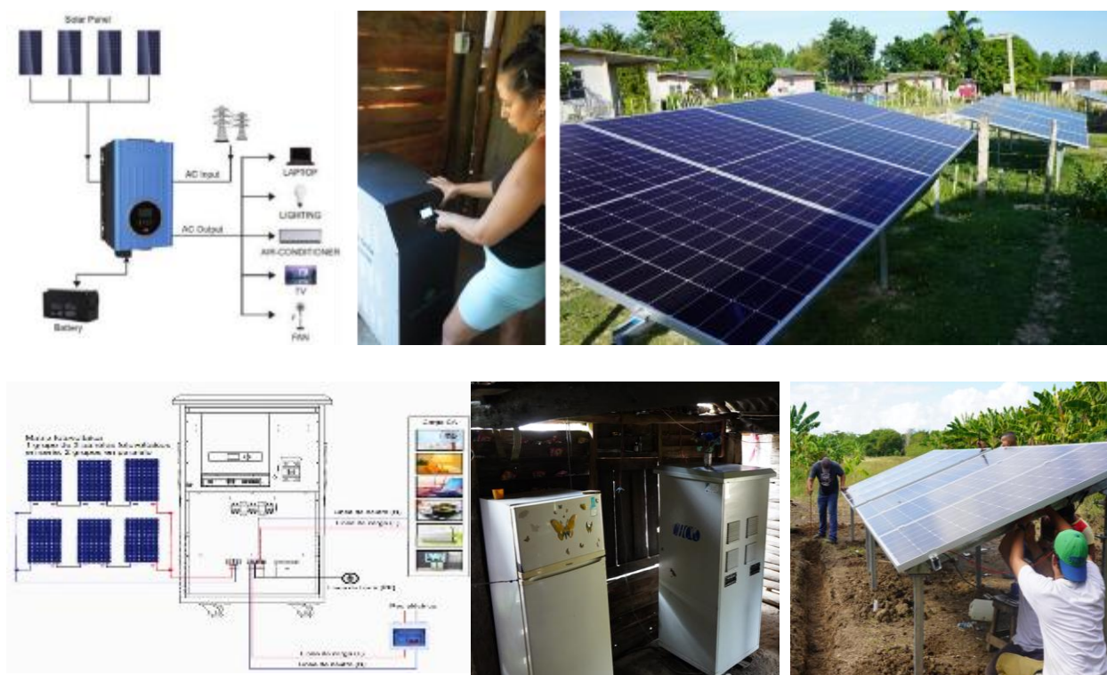
Fotos: Imágenes de los sistemas fotovoltaicos autónomos implementados. Fuente: Bases de Datos del Proyecto FRE local
