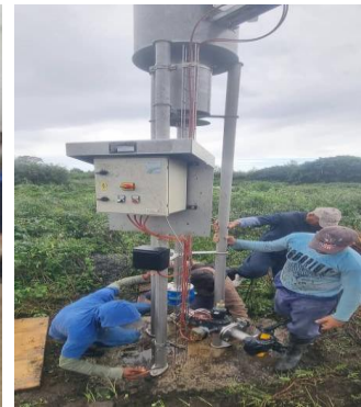
Fotos: Instalacion de balas de almacenamiento de biogás, bomba para extracción de lodo y antorcha. Fuente: Base de datos del Proyecto FRE local.
