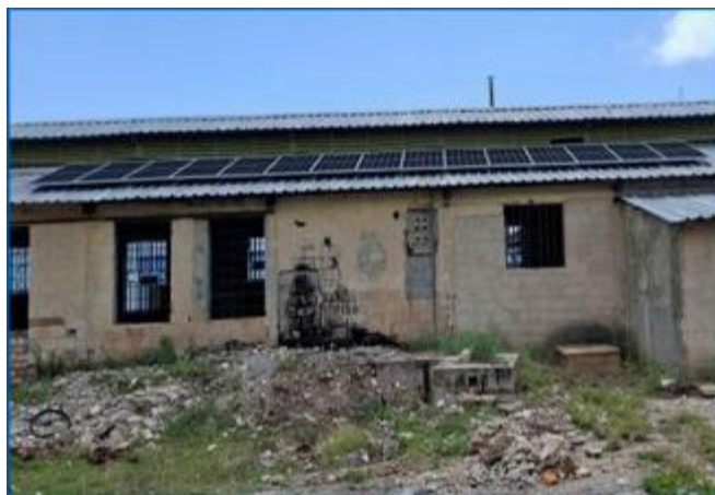
Foto: Área exterior de la instalación
