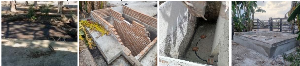
Fotos: Reconversión del foso de la vaquería 18. Fuente: Base de datos del Proyecto FRE local.
