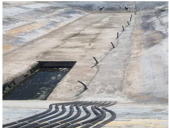
Fotos: Obra civil para la reconversión del tanque de maduración a biodigestor de laguna tapada y colocación de aspersores en el fondo. Fuente: Base de datos del Proyecto FRE local.
