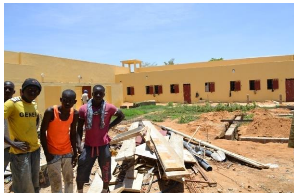
Photo 10 : Maison d'arrêt de GAO, travaux en cours
